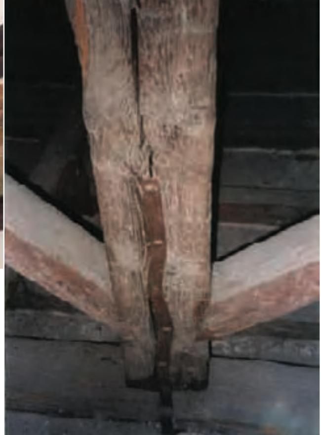
Eccessivo ed ingiustificato zelo. Le bellissime capriate della sede dell'IUAV ai Tolentini, le cui catene avevano evidenziato fessure da ritiro a causa del nuovo regime igrotermico degli ambienti restaurati ed utilizzati per la didattica, sono state vistosamente, quanto inutilmente cerchiate per timore di rottura. Nelle travi con cuore si possono abbassare le difese!
